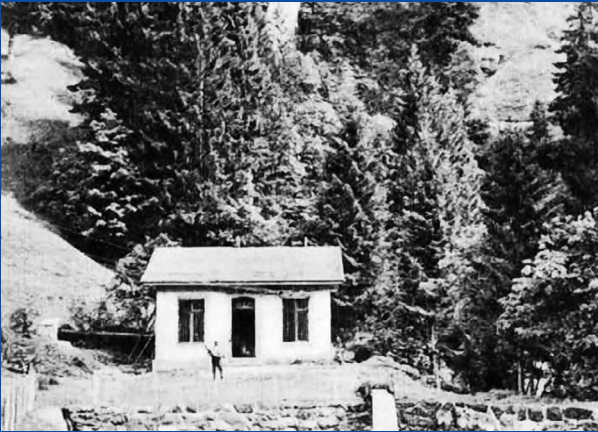
GLARUS – eines der ersten Hochdruck-Wasserkraftwerke Europas, erbaut von der Familie Legler im Jahr 1889.
